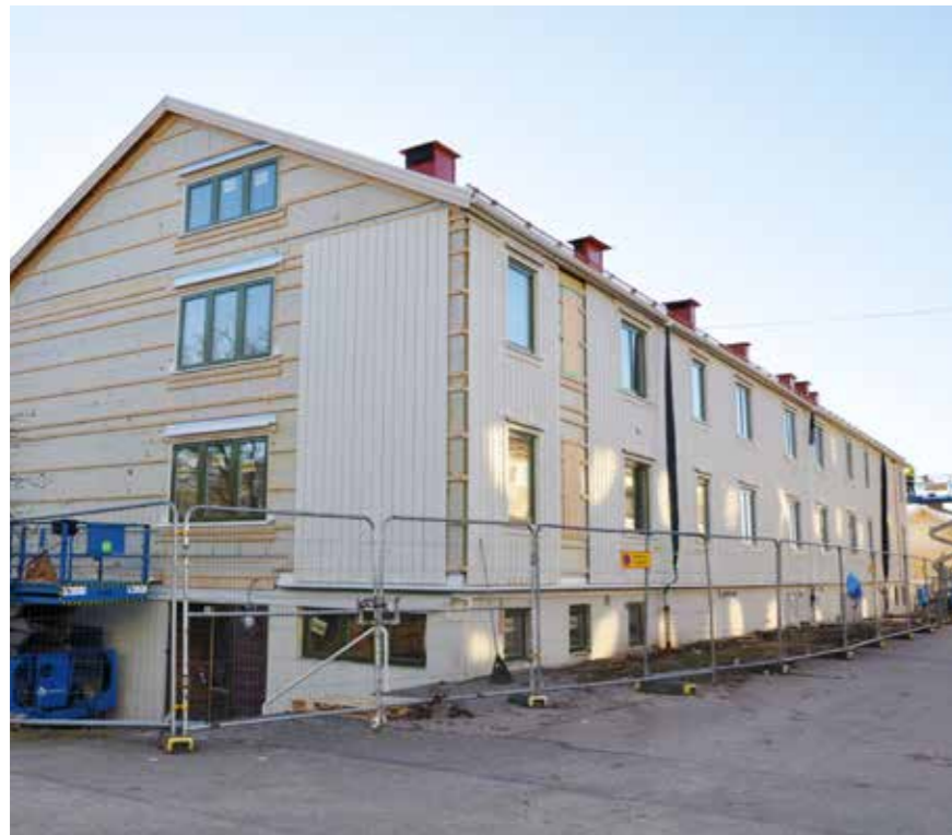
Fastighetsten på Bohusgatan under pågående renovering.
